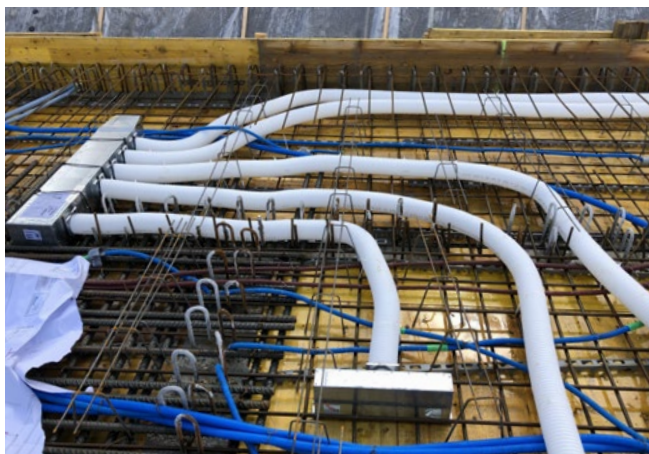
Exemples pratiques de dalles d'installation pour la construction de bâtiments
